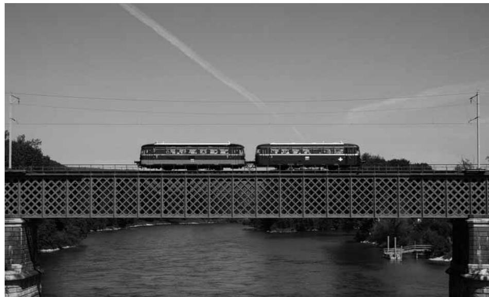
Rheinbrücke bei Koblenz
