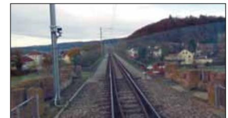
Nun passieren wir die Grenze und erblicken das erste **deutsche Signal: Ausführung 50 km/h** (Lf 7 Geschwindigkeits-signal 20002860 3.2.2). Gemäss RADN beträgt die Höchstgeschwindigkeit **40 km/h**.
