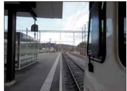
In Koblenz Gleis 4 zeigt das **Ausfahrtsignal** bzw. das **ausfahrseitige Gleisabschnittssignal Geschwindigkeits-Ausführung 40 km/h**.
