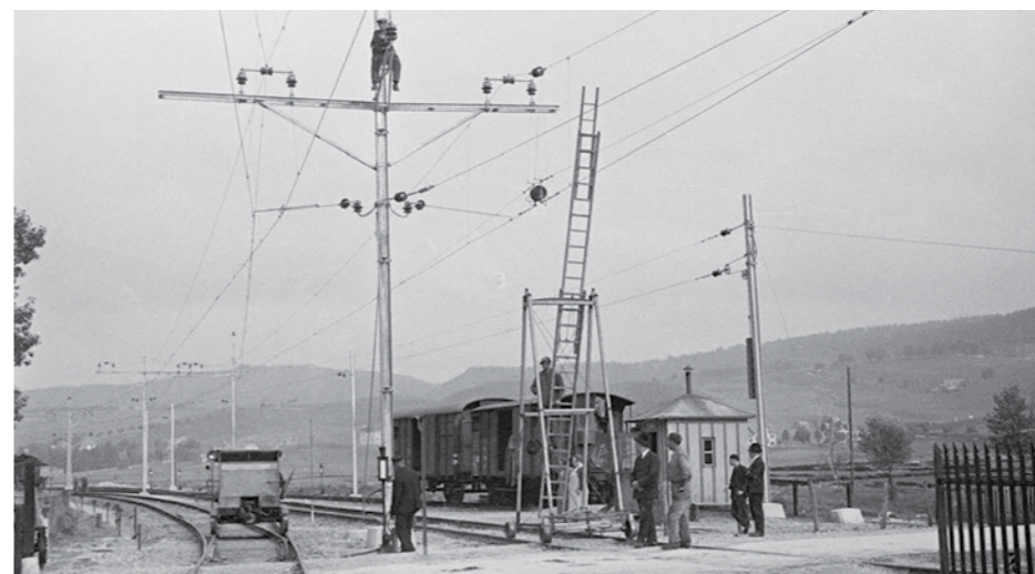
Elettrificazione della stazione di Le Locle-Col-des-Roches, inizio anni '30 (SBB Historic SL_31026_08).
