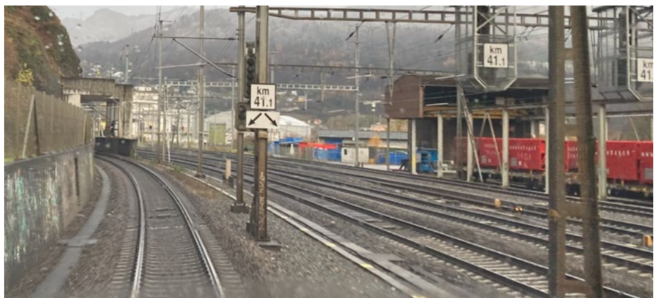
Bild 2 - «Merktafel für Änderung der Höchstgeschwindigkeit». Ab hier darf mit höchstens 90 km/h gefahren werden.
