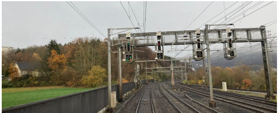
Bild 1 - Einfahrsignal, Vorsignal signalisiert 90 km/h ab dem Einfahrabschnitt
