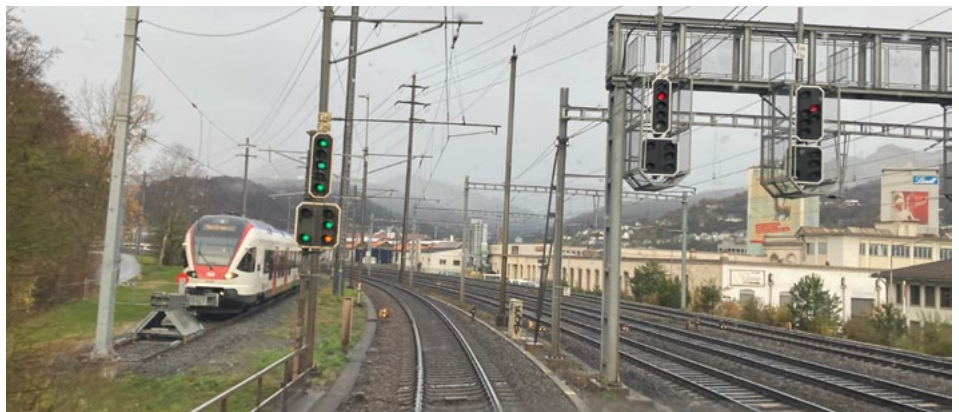
Bild 3 - Einfahrabschnitt-Hauptsignal. Ab hier erwartet der Lokführer die am Vorsignal signalisierte Geschwindigkeit von 90 km/h.
