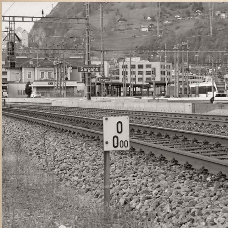
Der Km 0.00 auf der Höhe des alten (abgebrochenen) Bahnhofs östlich des jetzigen ist immer noch Ausgangspunkt der Kilometrierung in alle drei Richtungen. Bild: Hans Hidber
